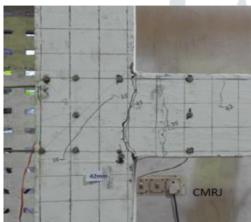
(b) CMRJ ultimate crack
