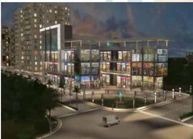
Fig 2: 3 rd eye view of actual site
