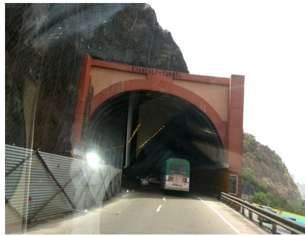
(d) Khandala Tunnel
