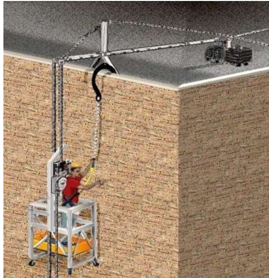
FIG 3 (d) SUSPENDED SCAFFOLD
